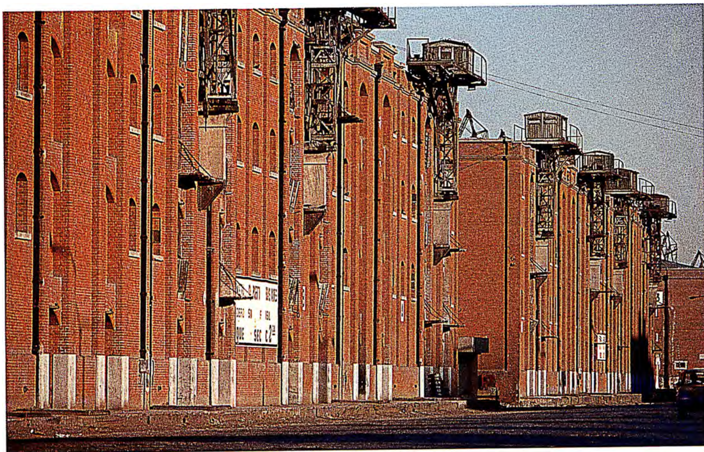
Puerto Madero, depósitos de las dársenas. Buenos Aires.
