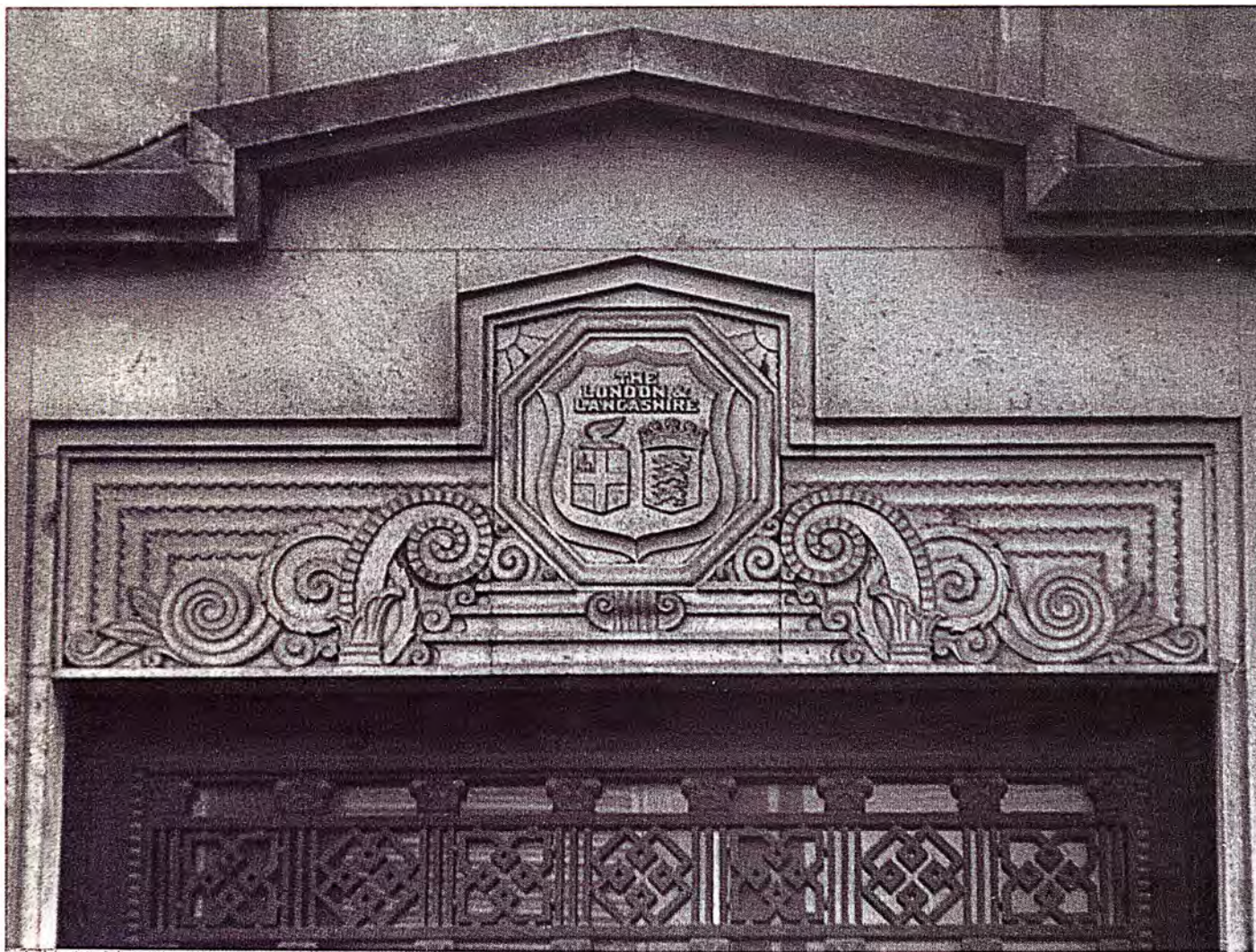
Calvo, Giménez y Jacobs, arquitectos. Detalle del portal principal de "The London & Lancashire Insurance Company". Buenos Aires.
