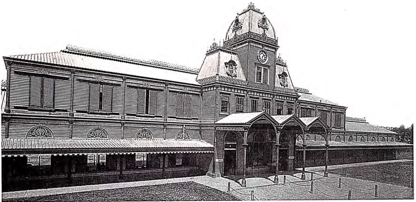
Buenos Aires, La "Estación Central", 1872-1897, Completamente prefabricada, iba a ser para Madrás, La India. La compró William Wheelright en Inglaterra.
