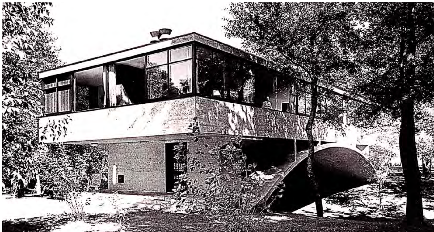
Amancio Williams, arquitecto. Casa llamada "del puente", en Mar del Plata, provincia de Buenos Aires.
