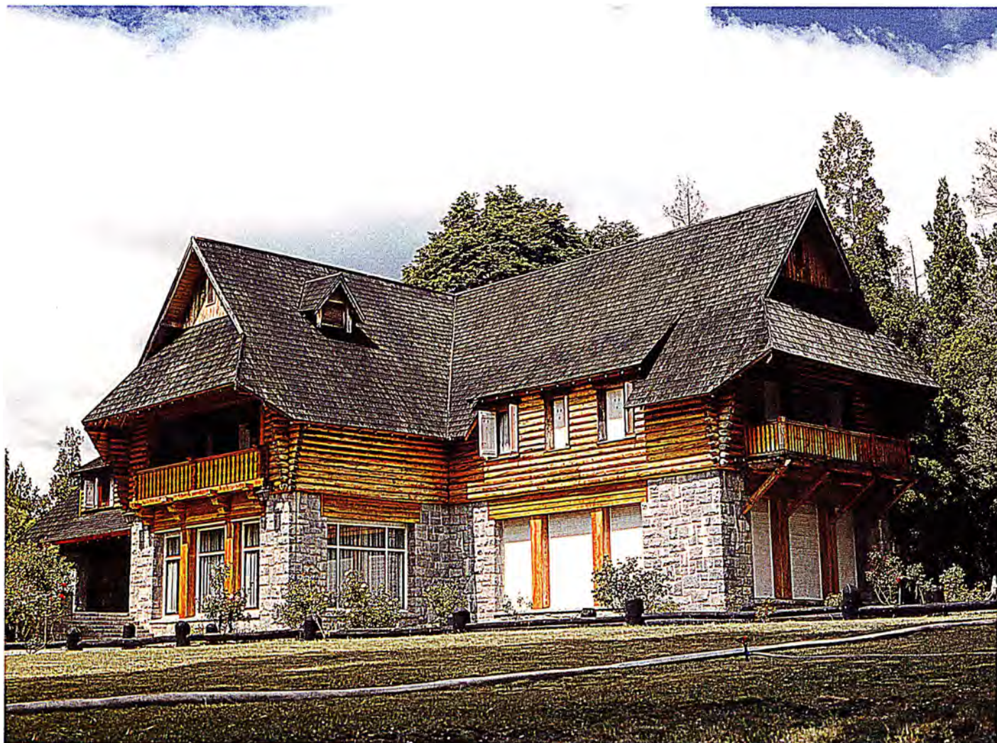
Alejandro Bustillo y Ernesto de Estrada, arquitectos. El Parador del Parque Nacional "Los Alerces", sobre el Lago Futalaufquén, provincia del Chubut.
