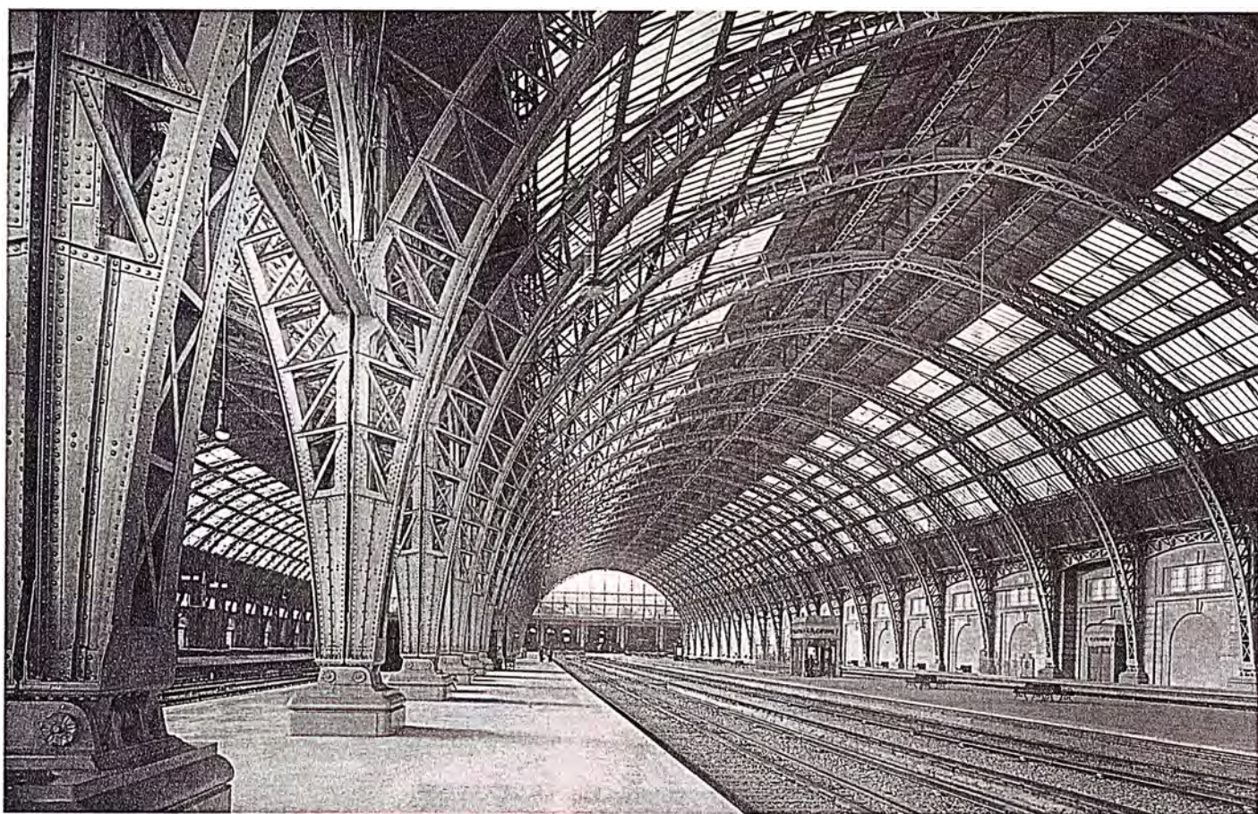
Eustace Lauriston Conder, Francis Farner y Sidney G. Follett, arquitectos, Reginald Reynolds, Ingeniero. Dos vistas de los andenes de la estación terminal de Retiro de la línea Mitre, ex Ferrocarril Central Argentino en Buenos Aires. Sus bóvedas metálicas tienen 44,88 m de luz libre cada una. Junio de 1909- agosto de 1915
