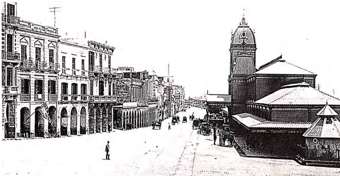
La "Estación Central" y el Paseo de Julio, Buenos Aires.
