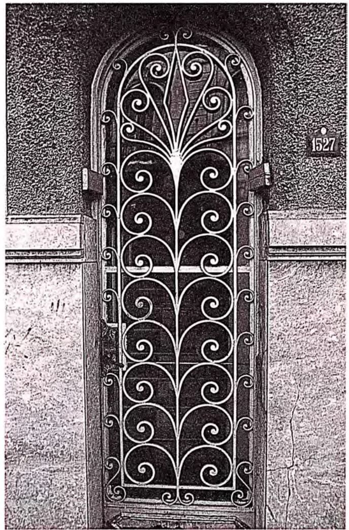
Vanoli y Quaglia, arquitectos. Detalle del almacén "Pompeo".
