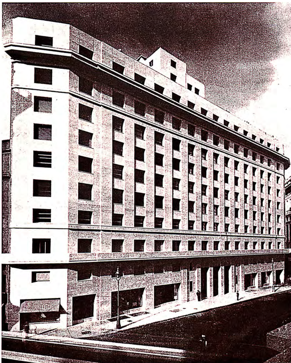
Edificio de Yacimientos Petrolíferos Fiscales, diagonal Roque Sáenz Peña , Buenos Aires. Fotografía de la Revista de Arquitectura.
