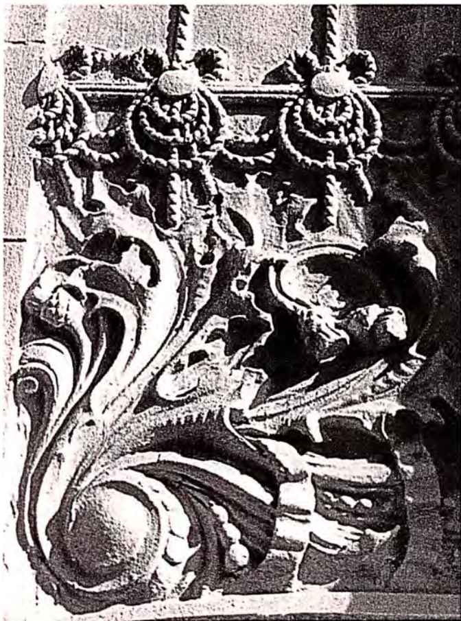
Bernardo Milli, arquitecto. Detalle de la fantástica decoración del "petit hotel" de la calle Suipacha 940, Buenos Aires.
