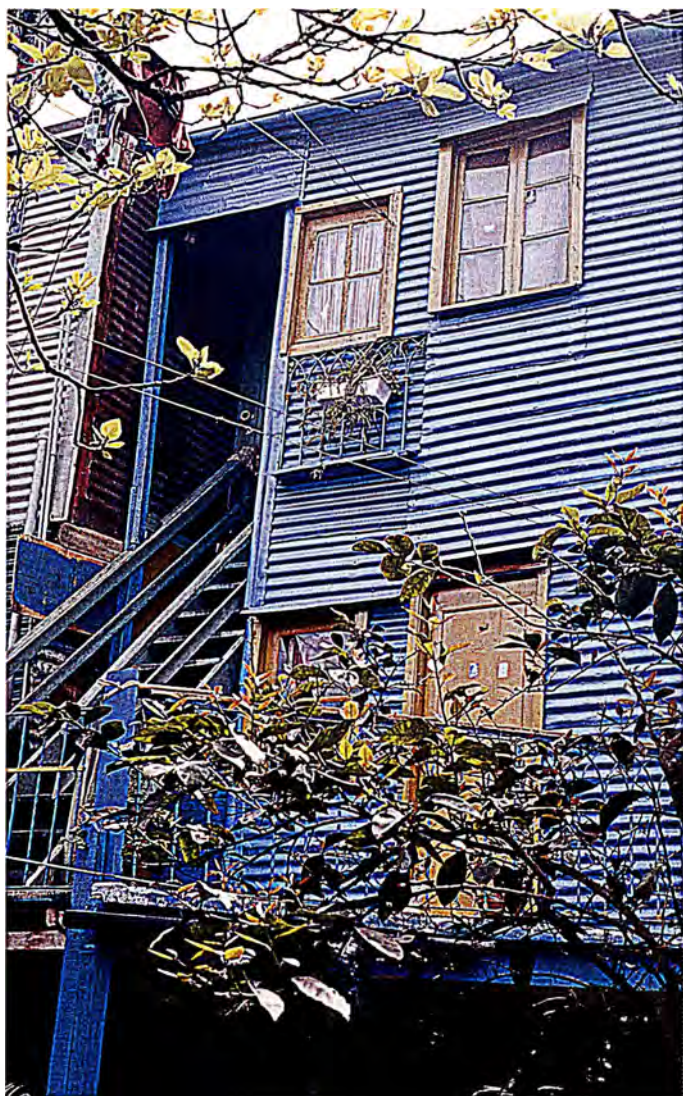
Prefabricación popular: la casa armada "en seco", de estructura puntual y cerramientos modulares de chapa acanalada, de los primeros pobladores de la Boca, Buenos Aires.
