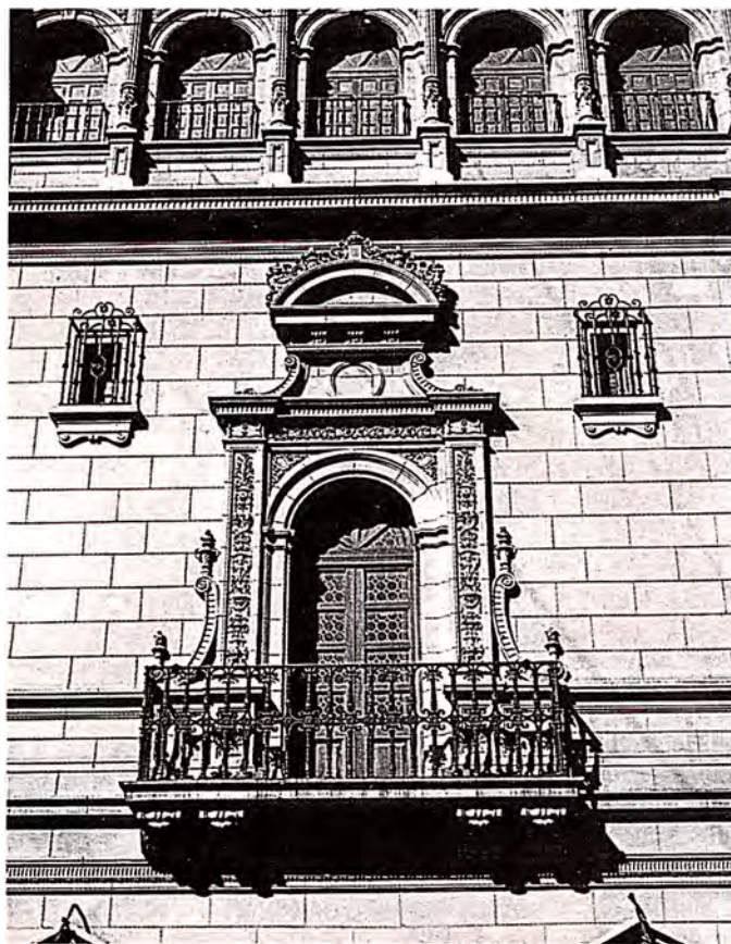
Vargas y Aranda, arquitectos. El Teatro Nacional Cervantes. Frente de la Avenida Córdoba, detalle. Buenos Aires. 1921.
