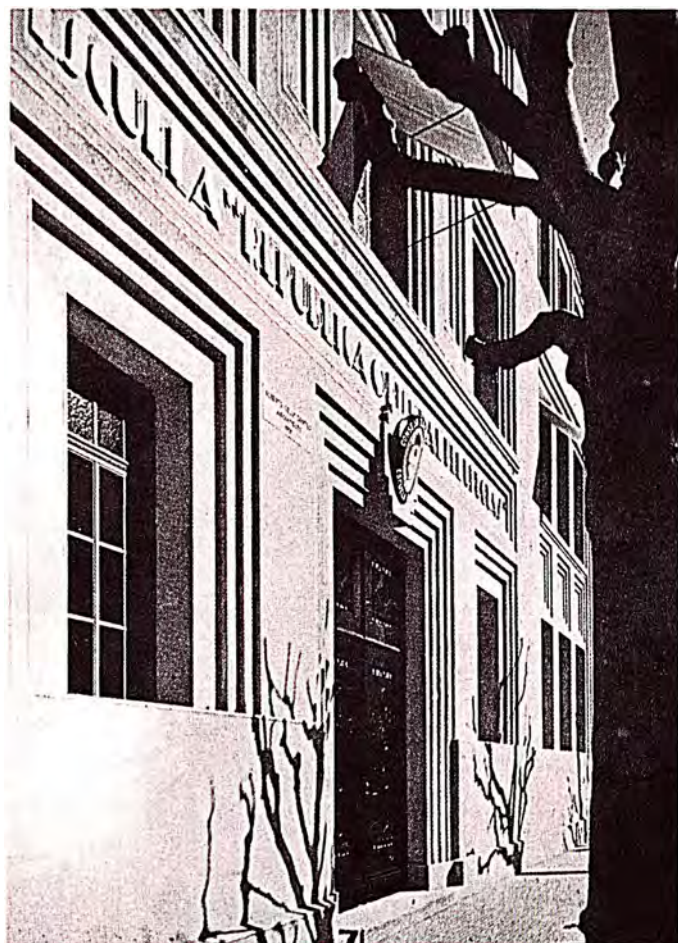
Alberto Gelly Cantilo, arquitecto. Escuela República Oriental del Uruguay de la Avenida Gaona. Buenos Aires.
