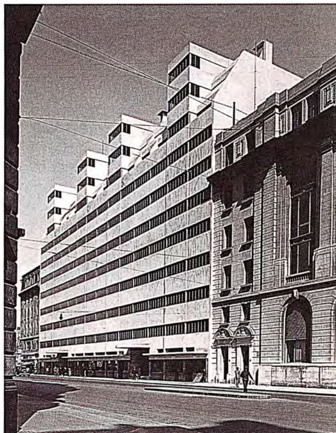
Raúl Eduardo Birabén, arquitecto. El edificio "Uruguay" en la calle homónima. Buenos Aires.
