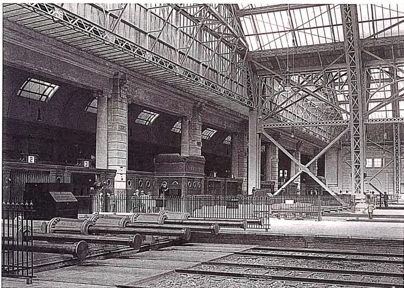
Eustace Lauriston Conder, Francis Farner y Sidney G. Follett, arquitectos, Reginald Reynolds, Ingeniero. Dos vistas de los andenes de la estación terminal de Retiro de la línea Mitre, ex Ferrocarril Central Argentino en Buenos Aires. Sus bóvedas metálicas tienen 44,88 m de luz libre cada una. Junio de 1909- agosto de 1915
