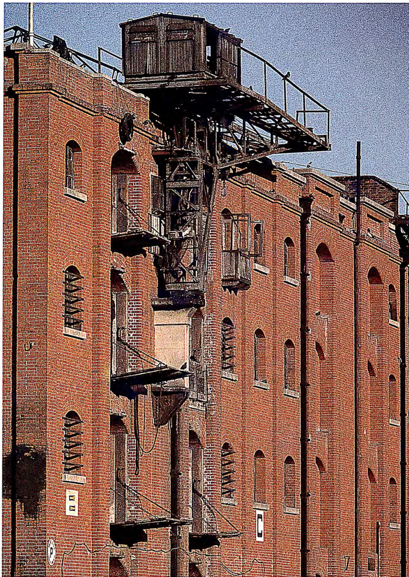
Puerto Madero, depósito de las dársenas en que se observa la estupenda mampostería estructural de ladrillo. Buenos Aires.
