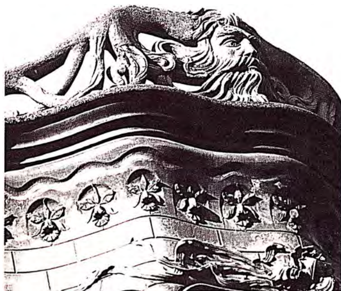
E. S. Rodríguez Ortega, ingeniero. Coronamiento del edificio de la avenida Rivadavia 2031, Buenos Aires.
