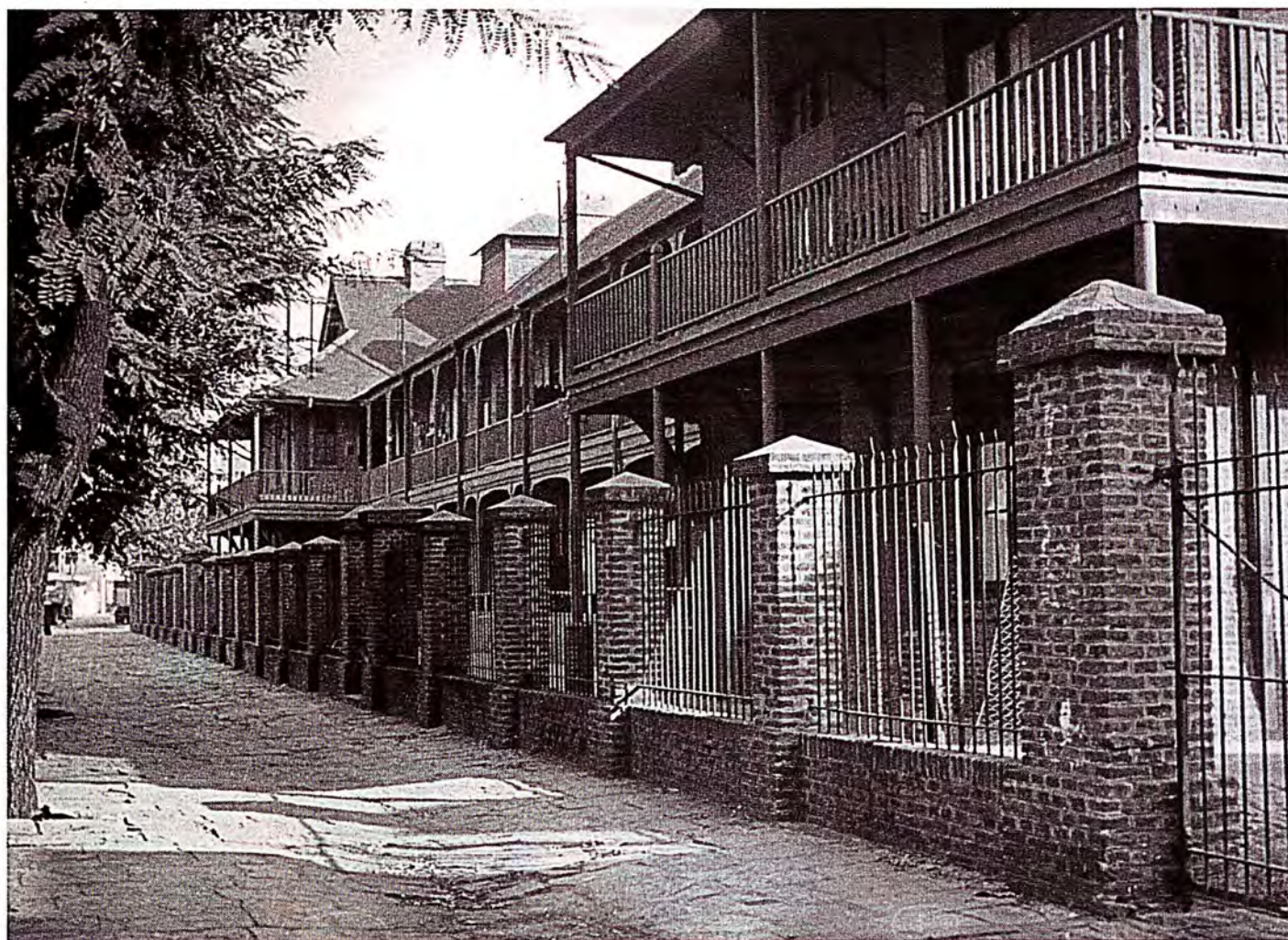
Casas del personal del Ferrocarril del Sud, en la calle Australia, Barracas, Buenos Aires.
