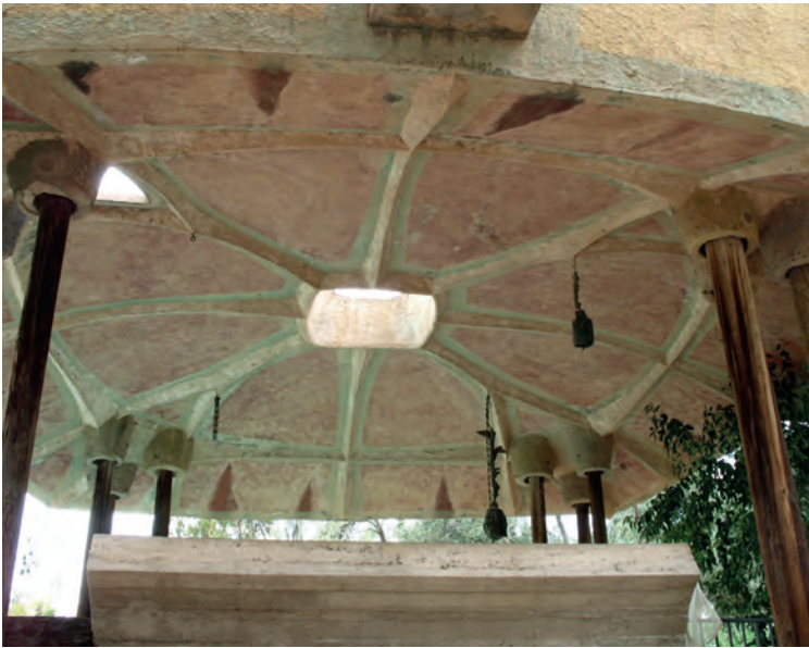
Paolo Soleri, Cosanti, inicio 1956; lift-slab sobre la alberca. (Foto LN)
