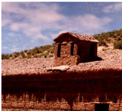
Detalle de una chimenea, la cubierta y muros. Todo resuelto en barro.
