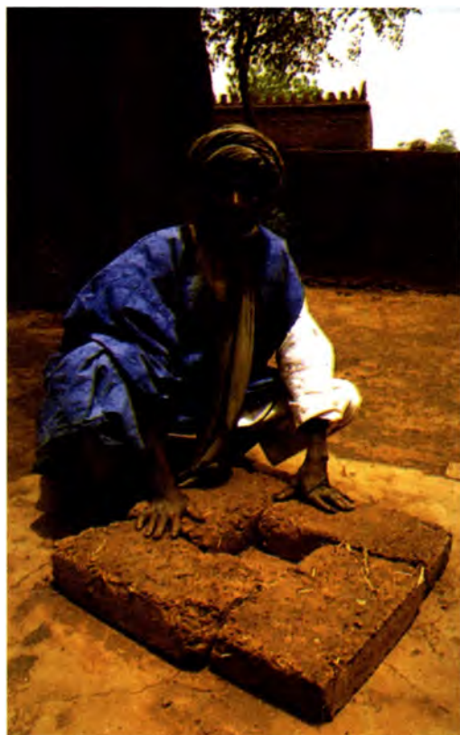
Fabricando adobes en Níger. Tomado de Vautbrin, 1996
