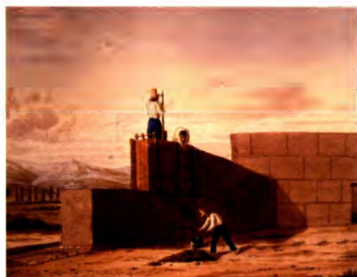
Construcción de tapias en Colombia, según Joseph Brown
