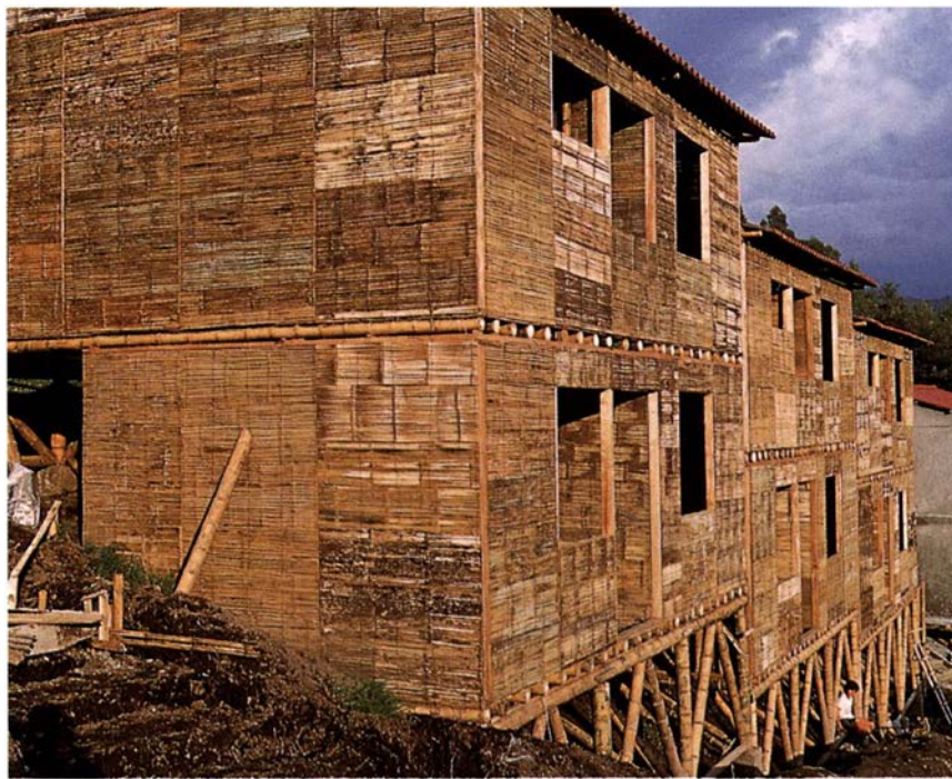
Figura 1. Autoconstrucción dirigida: el bambú como monomaterial, en Manizales (Colombia).
